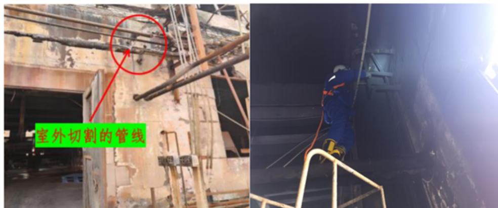
（图9 西区1楼室外管道切割位置） （图10 复盘常某西区1楼管道切割位置）
