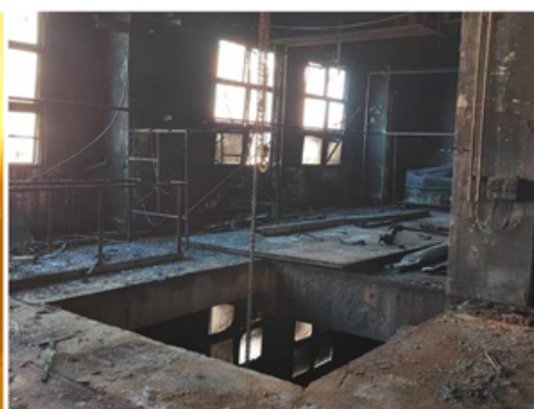
（图 12 1-2 楼间的吊装口）
